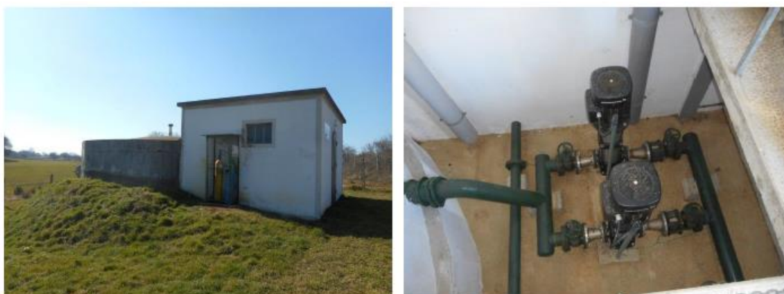
Figure 3 : Station de reprise d'Envoulon (source : Etude patrimoniale, Cabinet Merlin, 2019)
