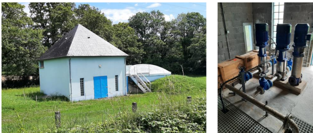
Figure 4 : Station de reprise Sacierges 2
